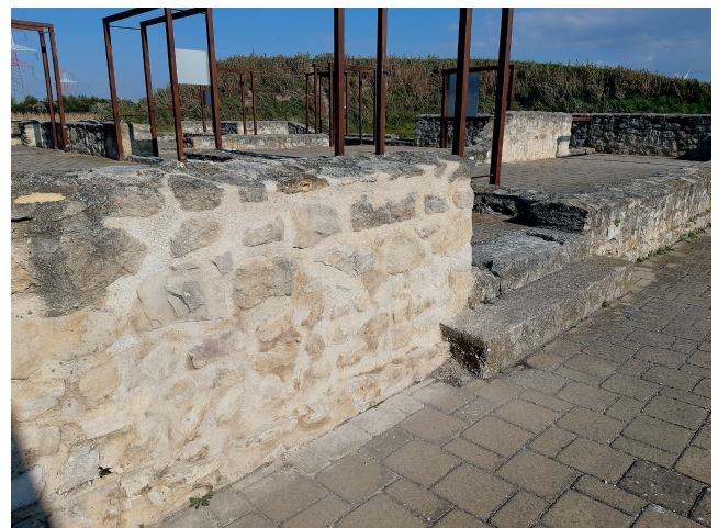
Abb. 2: Musterfläche 2 Raum 21, Begehung 10. Mai 2021
