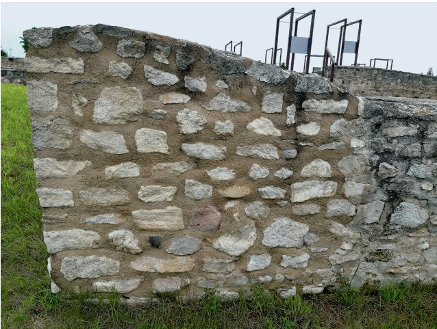
Abb. 3: Musterfläche 1 vor Raum 10, Begehung 11. Juni 2024
